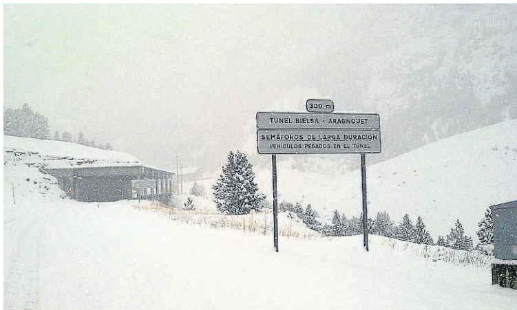
Aspecto que presentaba ayer el acceso al túnel de Bielsa. HERALDO
